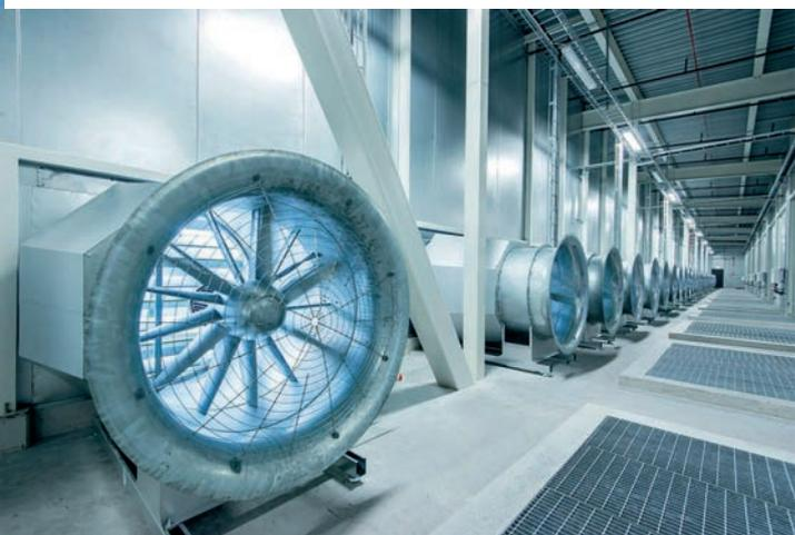
Воздушная система охлаждения появилась первой. Самый простой способ охладить что-то — подуть на горячее. Прямой фрикулинг — распространенный вид охлаждения, при котором тепло снимается путем прогона воздуха через оборудование напрямую с улицы. Горячий воздух затем снова «откидывается» наружу.
